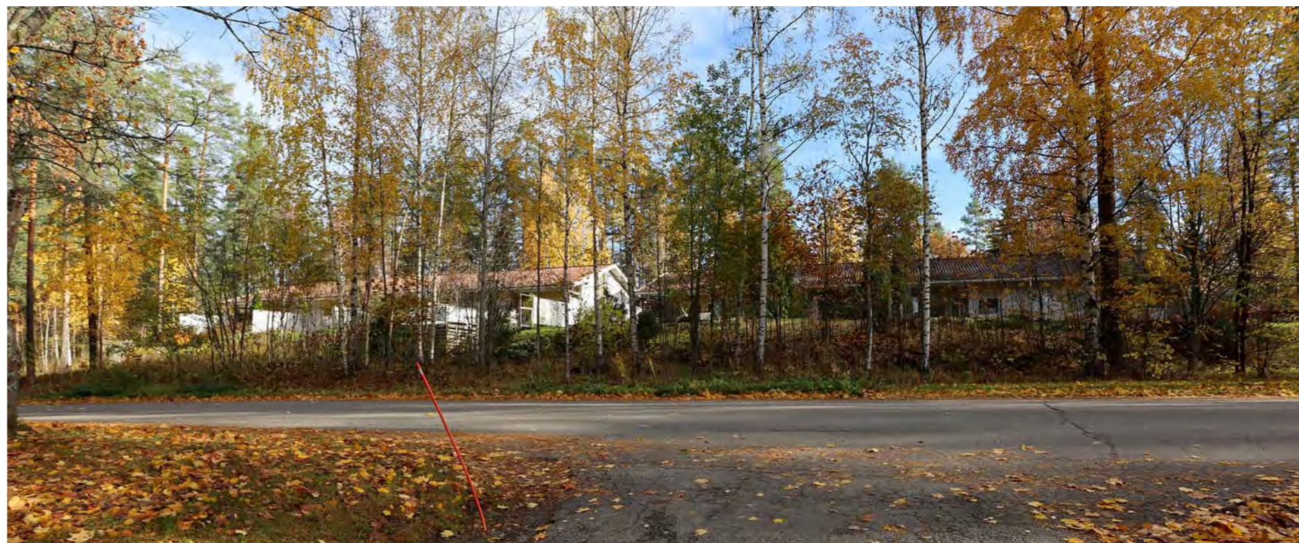
Kuva. 1980-luvulla rakennettuja rivitaloja Moisientien varressa.
