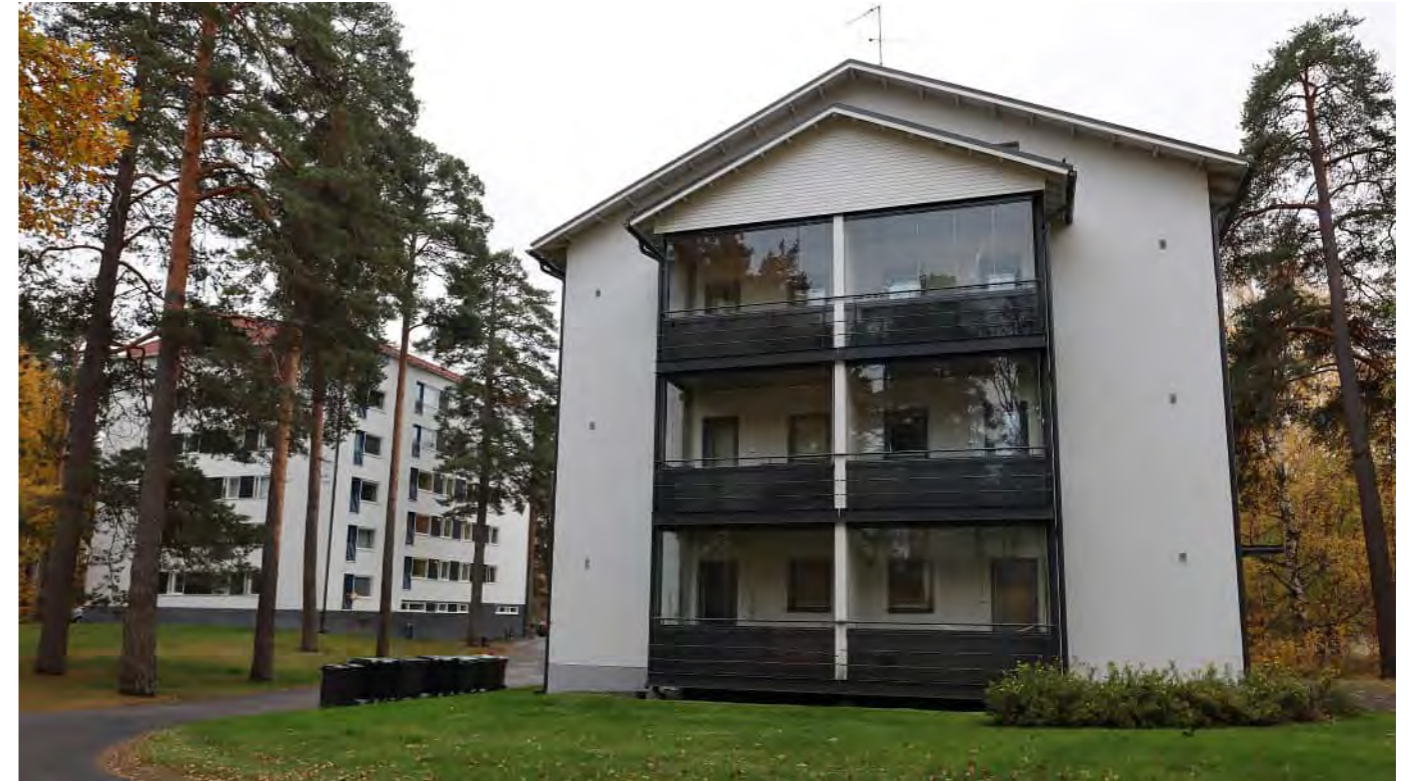
Kuva. Vasemmalla taustalla 1960-luvulla rakennettu kerrostalo, etualalla pistetalo. Rakennukseen on 2009 tehty julkisivukorjaus, jolloin myös parvekkeet on uusittu.
