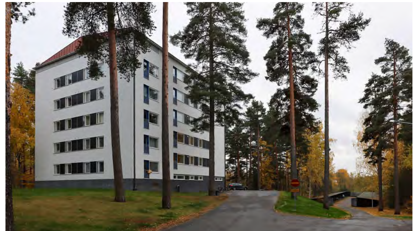
Kuva. Kerrostalo ja autotallit oikealla.
